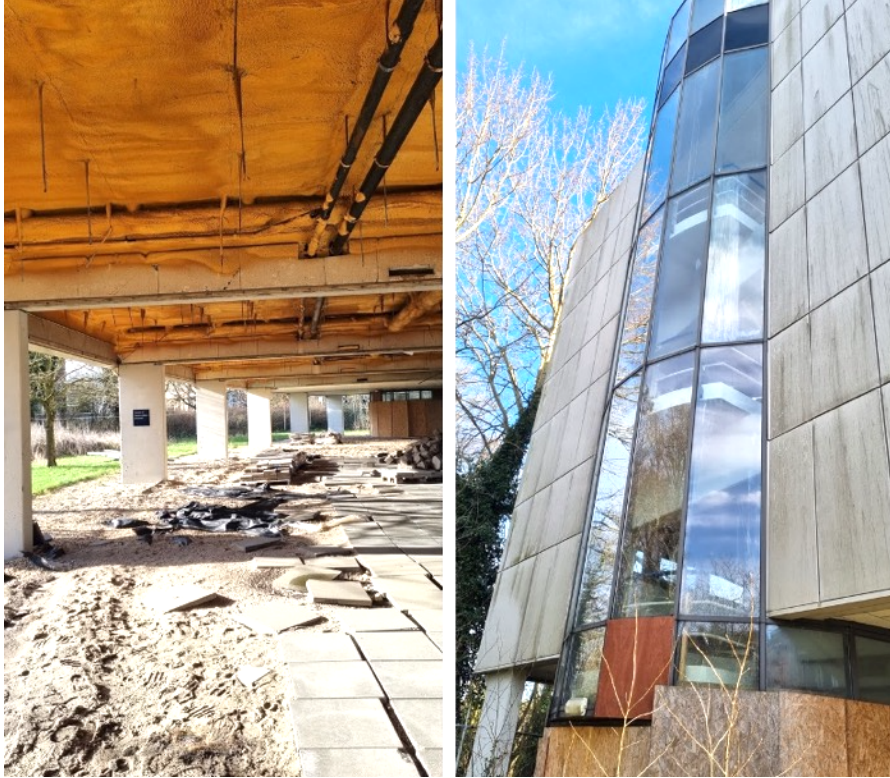
Afbeelding 8 en 9. Onderzijde en westzijde kantoorgebouw
