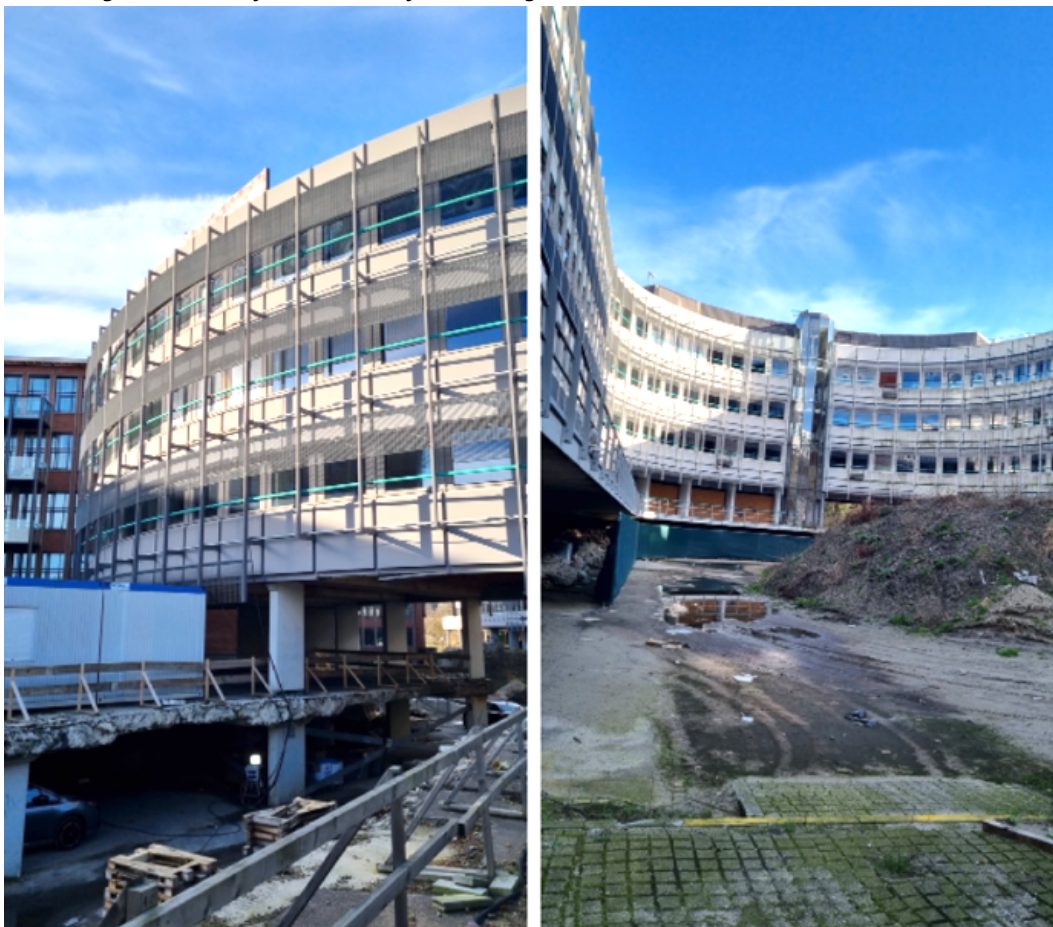
Afbeelding 6 en 7. Zuidzijde en binnenzijde kantoorgebouw
